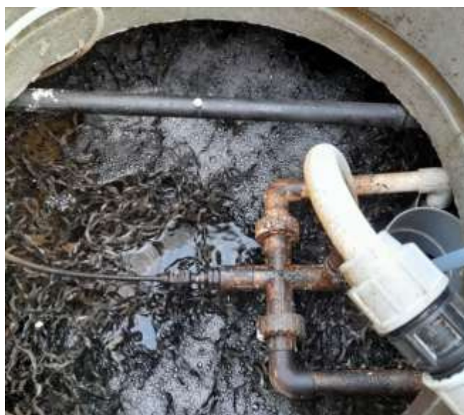
Figure 9 : Bullage fines bulles de qualité au sein du Média BIONEST
