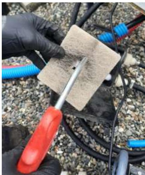
Figure 12: Nettoyage de filtre à air
