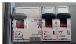
Disjoncteur remonté
