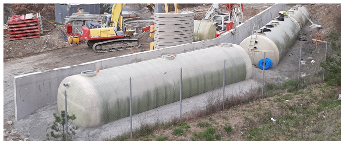
Filière Bionest 500EH en cours de réalisation
